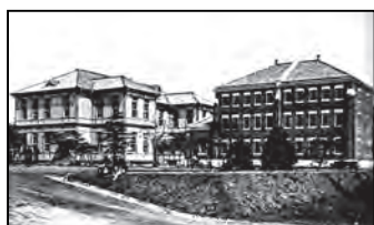
明治 35 年竣工図書館と書庫
