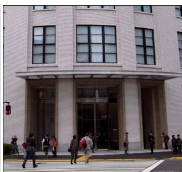
正面玄関になった感の駅側東入口
