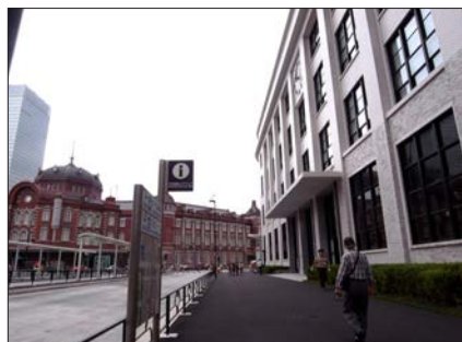
改装なった建物の2ショット
