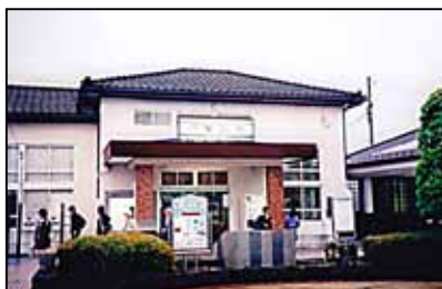
石巻線 女川駅（宮城県）津波により流失
