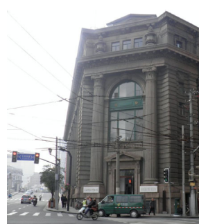
(写真1) 旧“上海郵政大楼”
