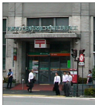
改装前駅側東入口
