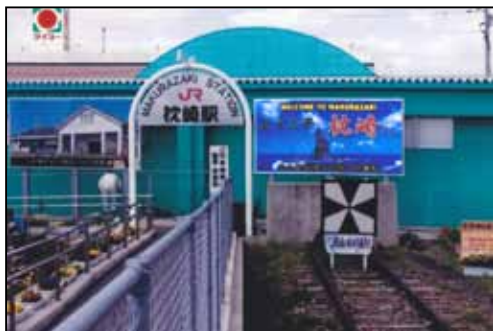
枕崎駅（鹿児島県）
