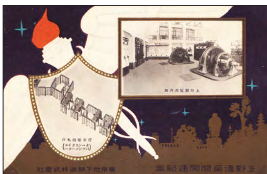
上野変電所内部
