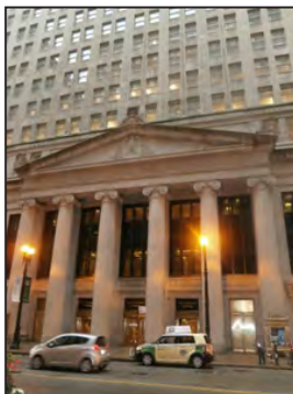
(写真14) シカゴ連銀ビル
