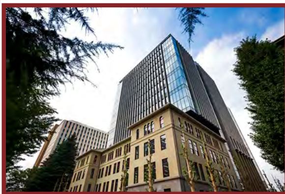
9 月 18 日、竣工した新 3 号館 旧 3 号館外観を再現した地下 2 階、地上 14 階、高さ 67.84 m （大学ホームページより）
