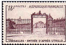
入口からみた宮殿遠景
