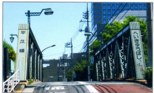
平久橋（ポニートラス構造）
